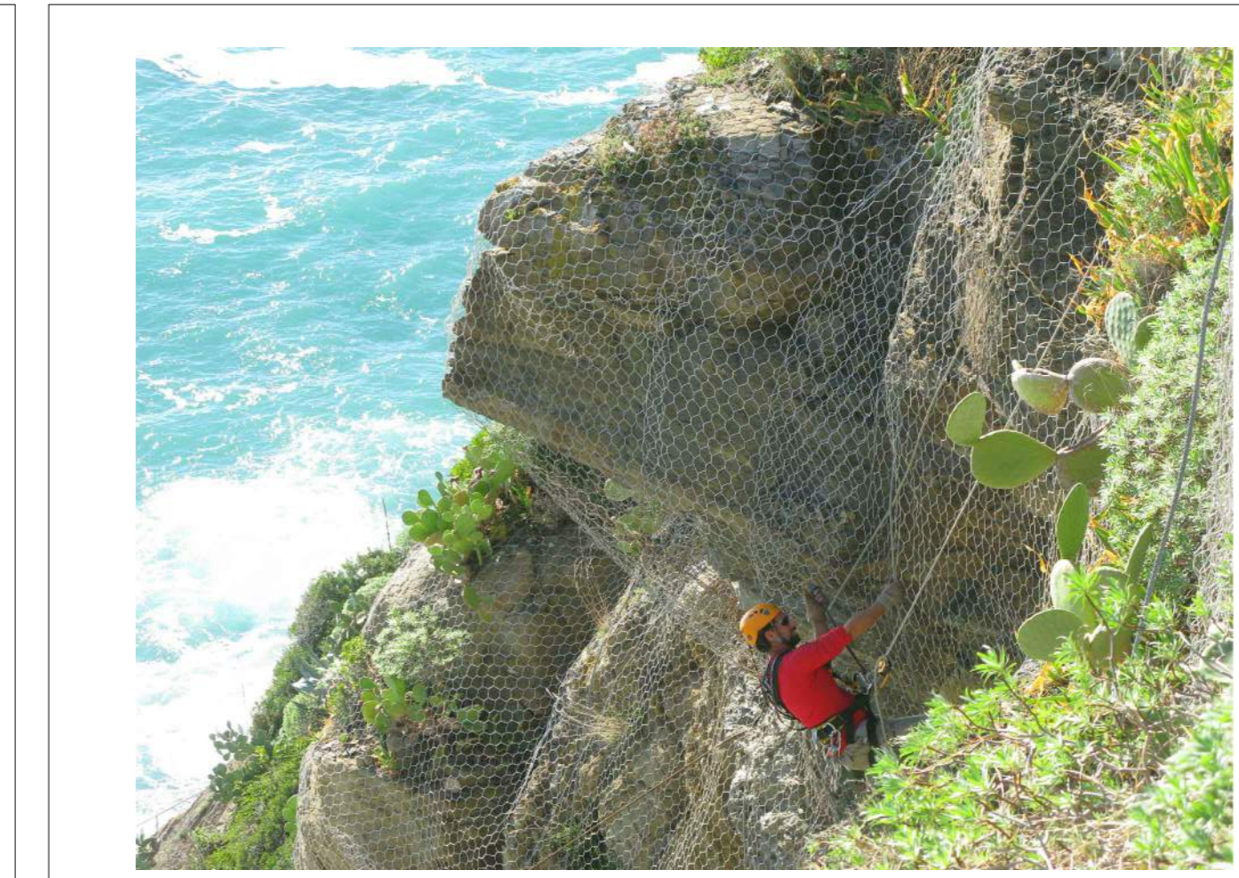
AMBITO AB INT. A3: intervento sottodimensionato per il volume roccioso aggettante
