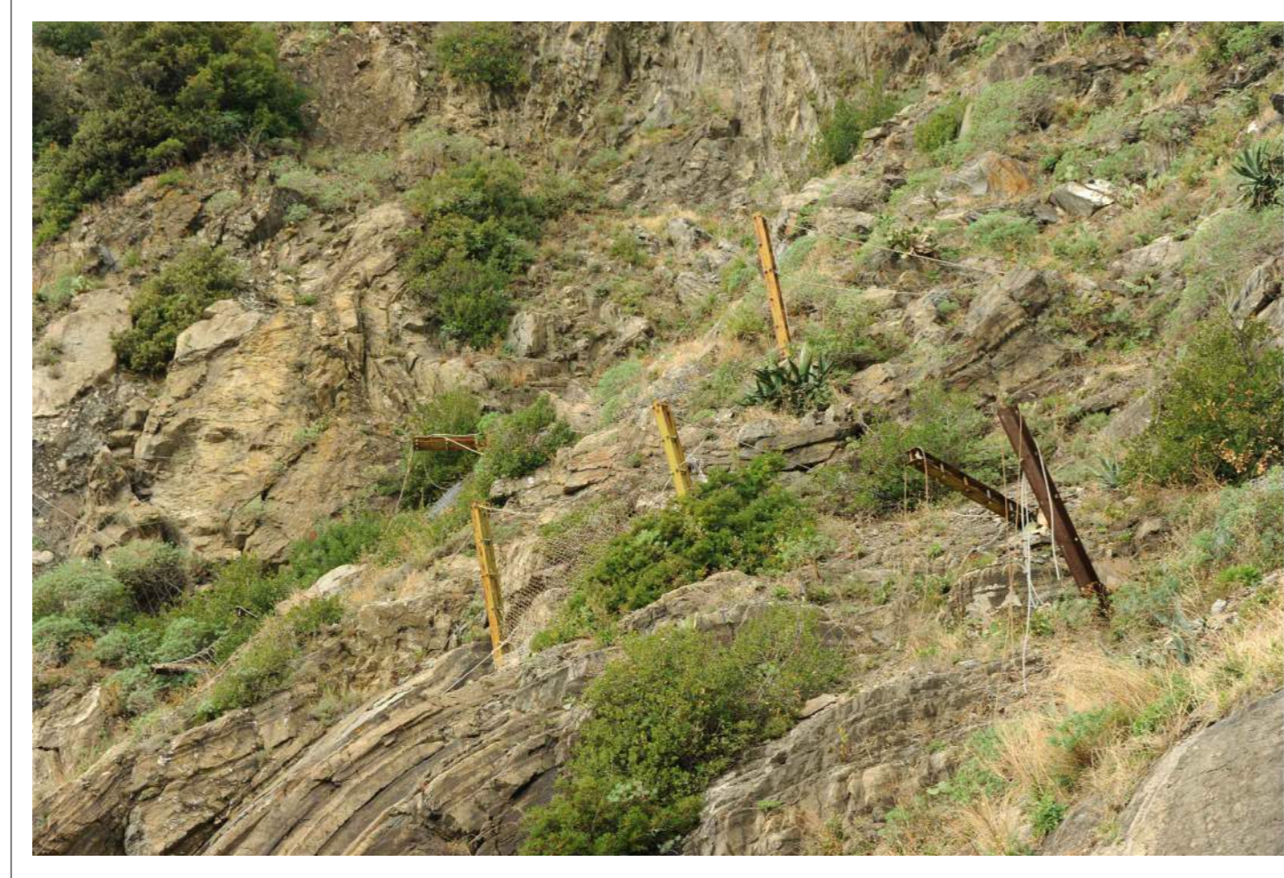
AMBITO DC INT. D1: barriere rigide completamente distrutte
