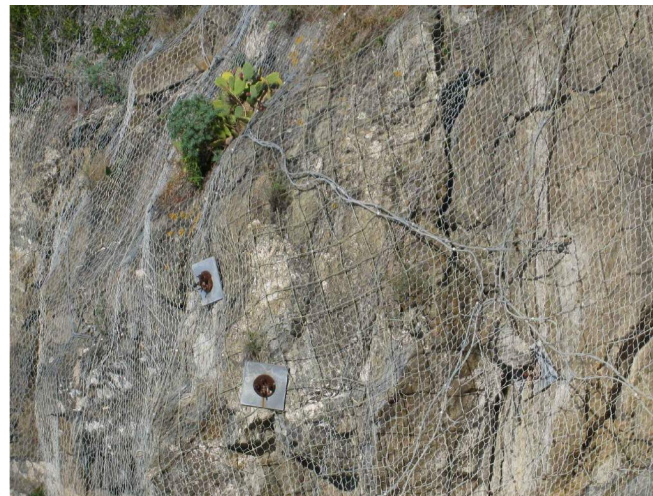
AMBITO CD INT. C/D 1: tiranti paralleli alle fratture
