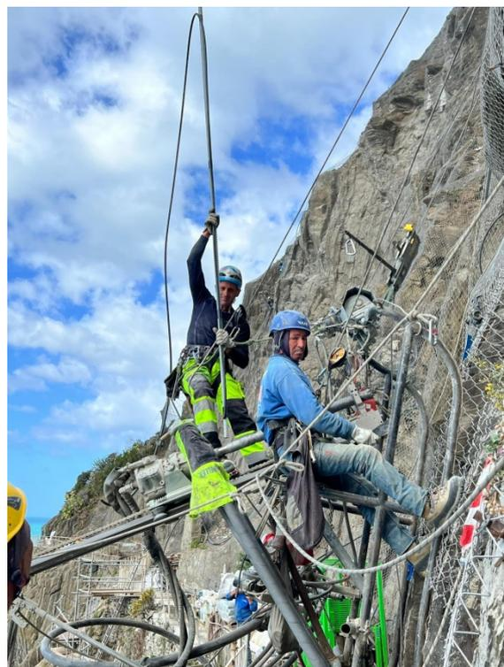
Figura 4 e 5 - operazioni di perforazione delle chiodature
