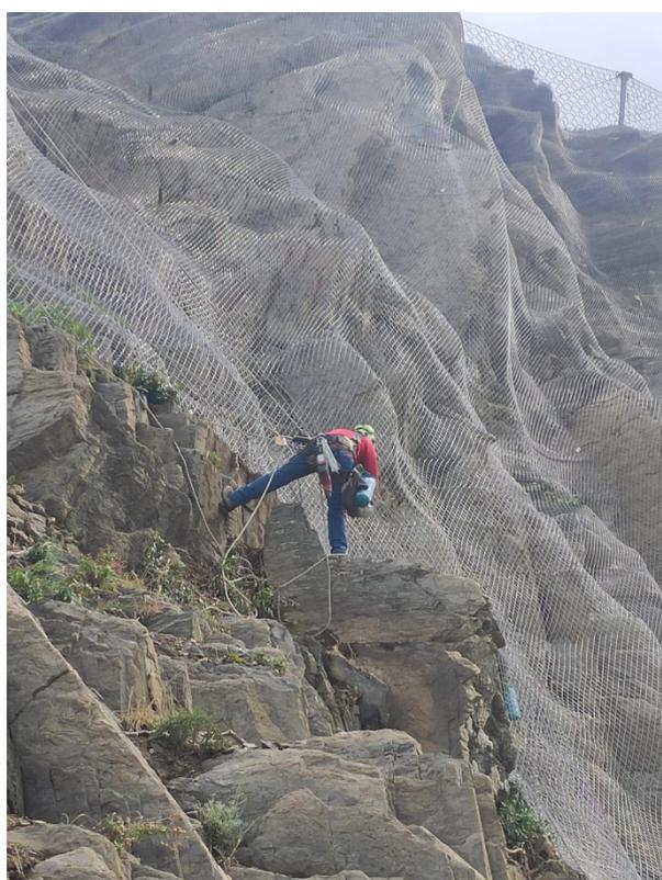
Figura 7 e 8 - rete in acciaio inox Tecco della Geobruigg
