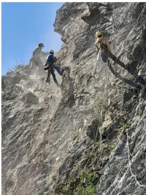
Figura 1 - operazioni di chiodatura
